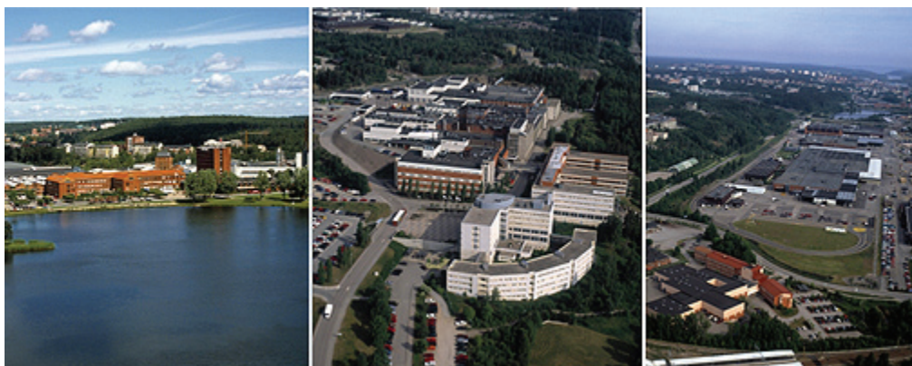
Uppdraget har utförts inom Scanias fabriksområde i Södertälje.
